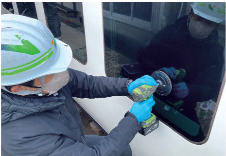
▼／▼清掃の様子。写真左は、手洗い洗浄をしているところ、写真右は、超親水防汚コーティング施工のための研磨作業をしているところ。
