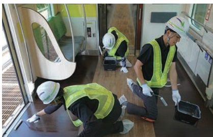
▲床面へのコーティング施工の様子。
