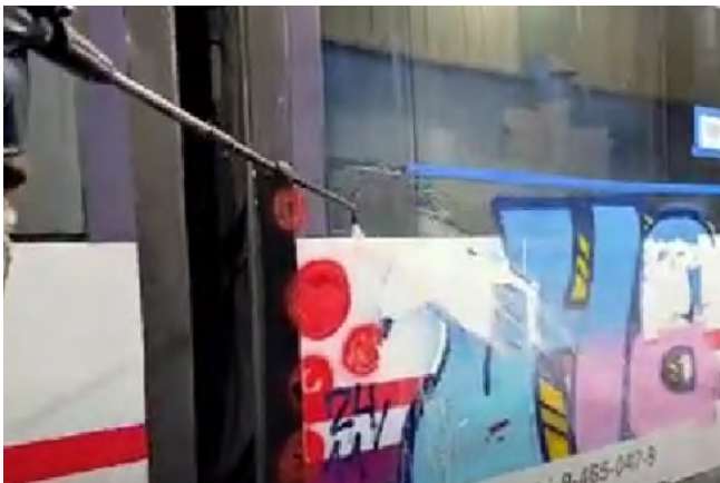
高圧洗浄水によるラッカー塗膜除去
