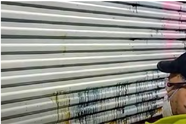
高圧洗浄水によるラッカー塗膜除去
